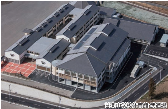
甘楽中学校体育館・武道場
