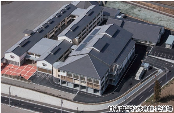
甘楽中学校体育館・武道場
