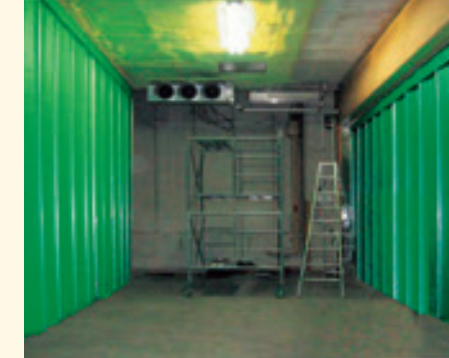
断熱(冷蔵) 断熱シート、D40レール、間仕切ポール使用
