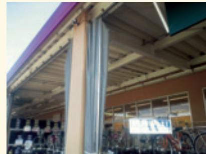
防塵 雨・風除け 日除け メッシュシート、D40レール使用
