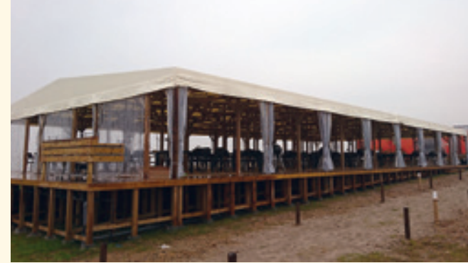
雨・風除け ビニール・テントシート、D30・D40レール使用
