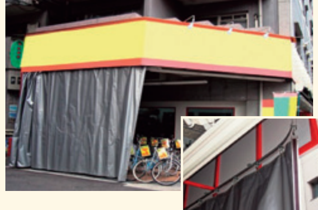
防塵 雨・風除け ビニールシート、ベンダーレール、間仕切ポール使用
