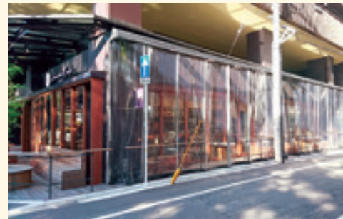
防塵 保温・保冷 雨・風除け ビニールシート、D40レール使用
