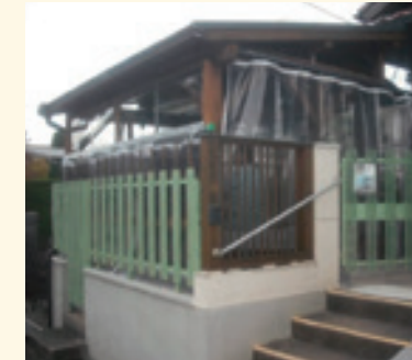
雨・風除け 防塵 ビニールシート、D30レール使用
