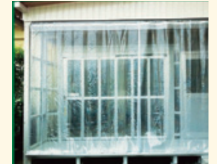
雨・風除け 防塵 ビニールシート、D40レール使用
