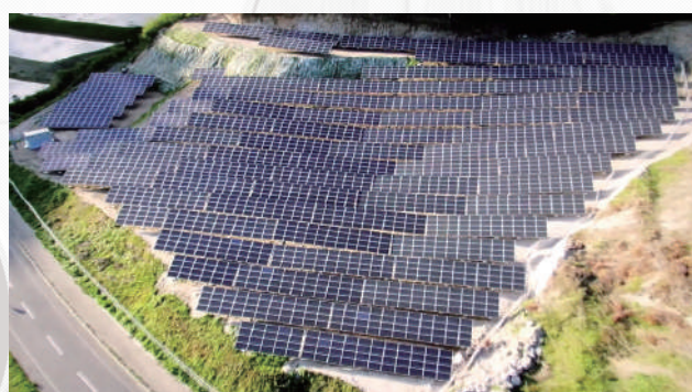
西尾木材岩手県堀切発電所 (933kW)
