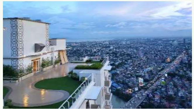
コンドミニアム屋上とマニラの街並み
