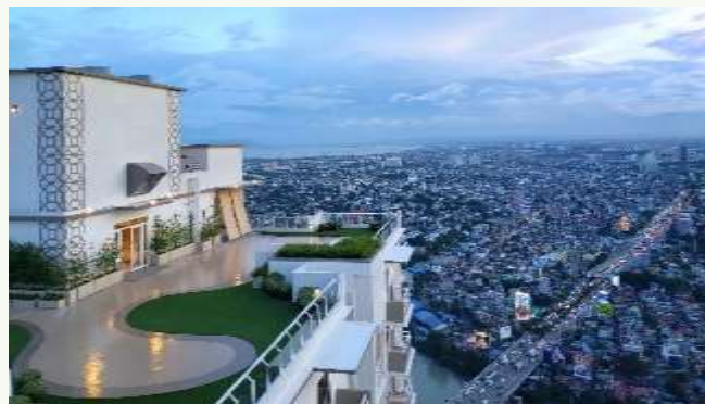
コンドミニアム屋上とマニラの街並み
