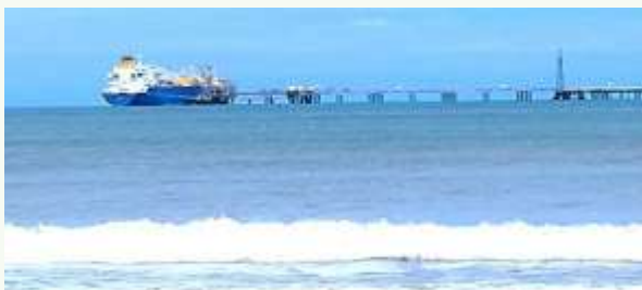
4.5kmある栈橋を通じて LNG 船へ積込
