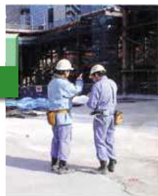
現場打ち合わせ状況
