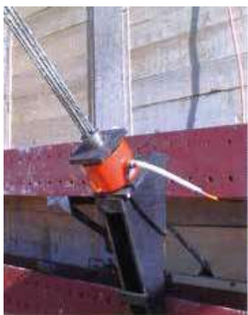
バックアンカー軸力計設置状況
