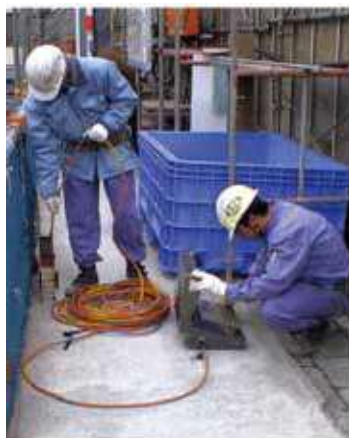
山留め壁の変形計測状況
