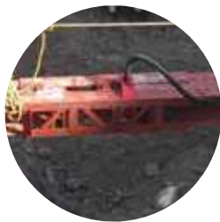
切梁軸力計測
