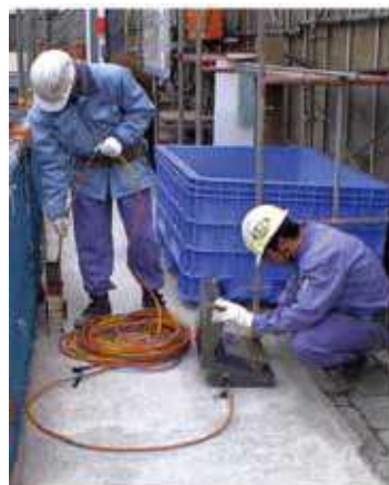
山留め壁の変形計測状況
