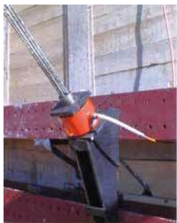
バックアンカー軸力計設置状況
