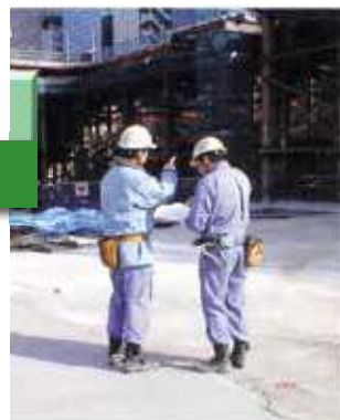
現場打ち合わせ状況
