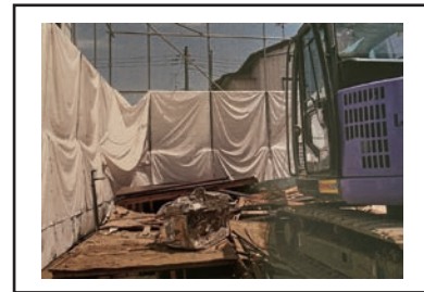
(重機による解体の様子)
