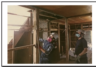
(内装解体の様子)
