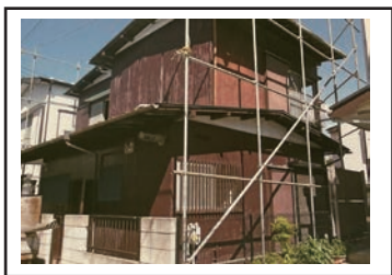
(単管パイプ組上げ)
