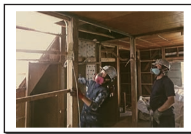
(内装解体の様子)
