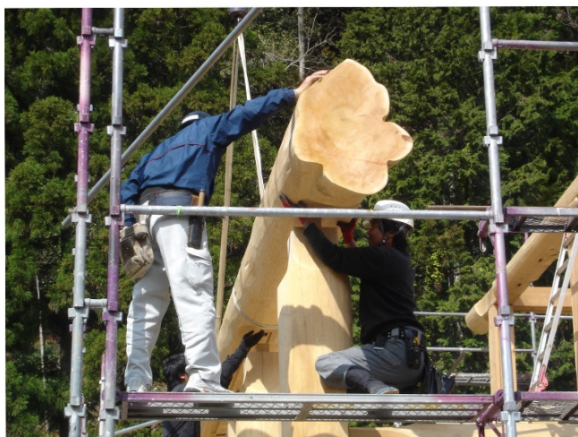
棟木や母屋の木口は大胆にレッドシダーならではの フレア材(根材)を意匠として見せます。
