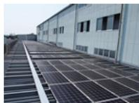
第1工場では再生可能エネルギー活用の取り組みとして、屋上にソーラーパネル(300w×245枚/総発電量:73.5kw)を設置しています。
