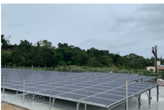
ソーラーパネル設置工事
