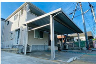
カーポート設置工事
