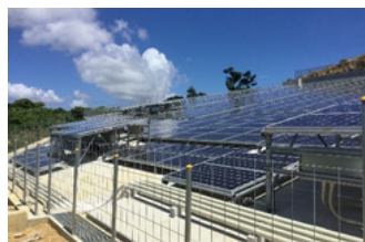
ソーラーパネル設置工事
