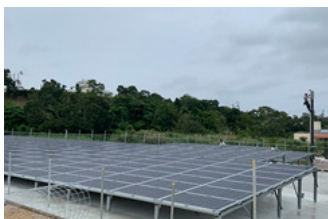
ソーラーパネル設置工事
