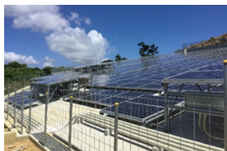
ソーラーパネル設置工事
