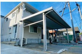
カーポート設置工事
