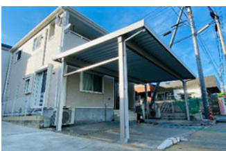
カーポート設置工事
