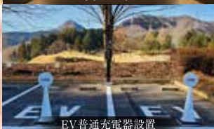
EV普通充電器設置
