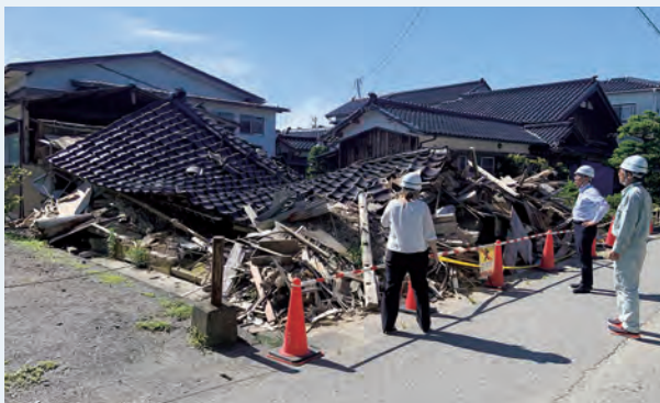
令和6年1月1日地震発生直後の状況及び支援活動の状況
