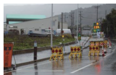
道路補修工事 (鹿児島県)
