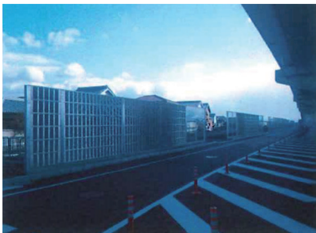
■ 奈良国道 遮音壁設置
