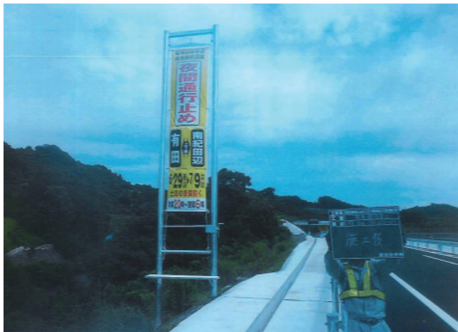
■ 阪和自動車道 懸垂幕装置設置
