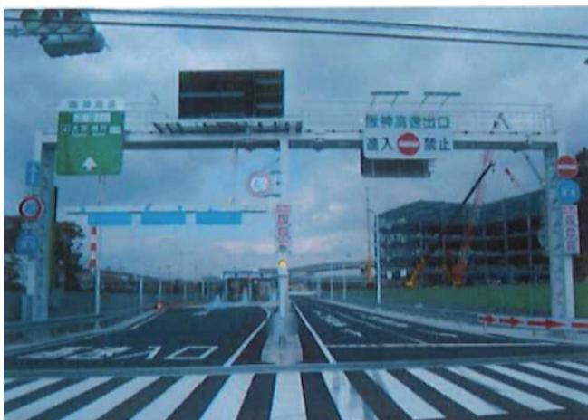
■ 阪神高速湾岸線 三宝入路 標識設置
