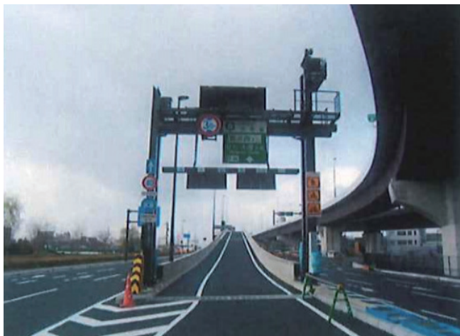
■ 阪神高速京都線 鴨川西入路 標識設置
