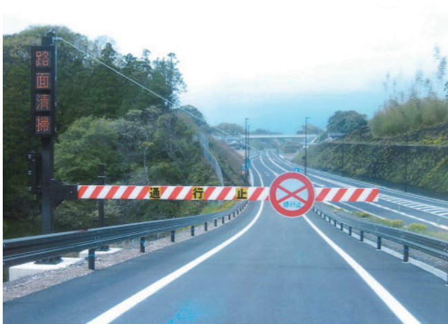
■ 紀勢自動車道 通行止め装置設置
