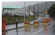
道路補修工事 (鹿児島県)
