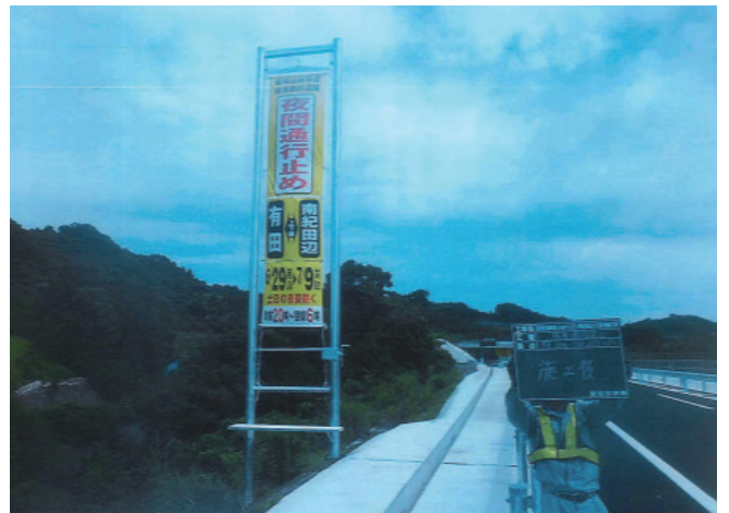
■ 阪和自動車道 懸垂幕装置設置
