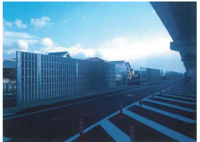
■ 奈良国道 遮音壁設置
