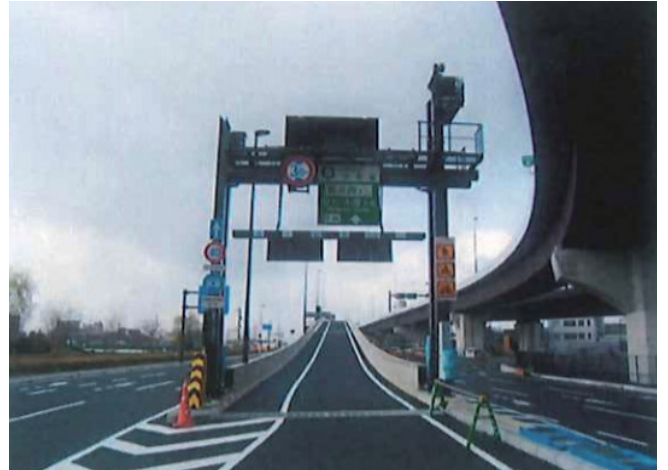
■ 阪神高速京都線 鴨川西入路 標識設置
