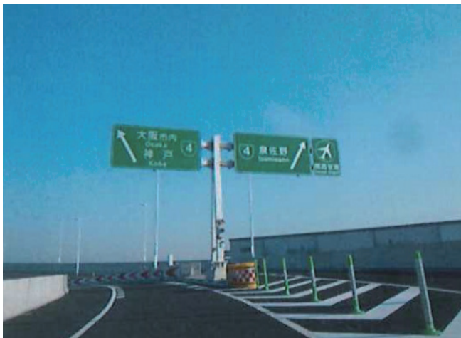
■ 阪神高速湾岸線 三宝JCT 標識設置
