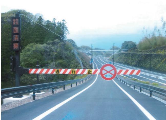
■ 紀勢自動車道 通行止め装置設置
