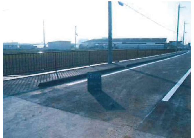
■ 泉南市 交通安全施設設置 (転落防止柵)
