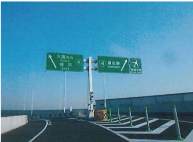
■ 阪神高速湾岸線 三宝JCT 標識設置
