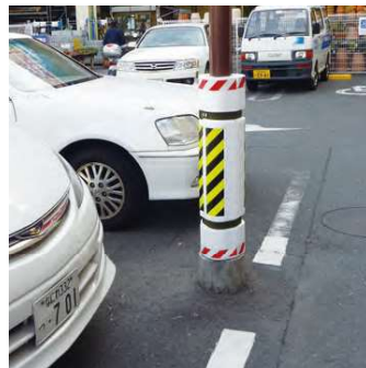
照明柱の防護に。
