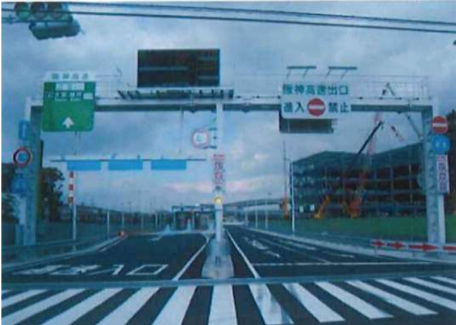
■ 阪神高速湾岸線 三宝入路 標識設置
