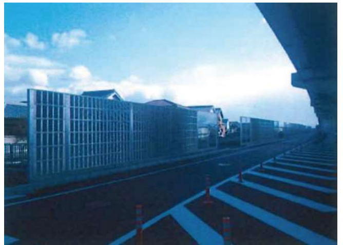
■ 奈良国道 遮音壁設置
