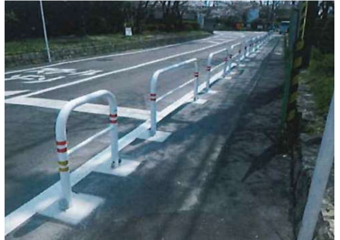
■ 岸和田市 交通安全施設設置 (車止め)
