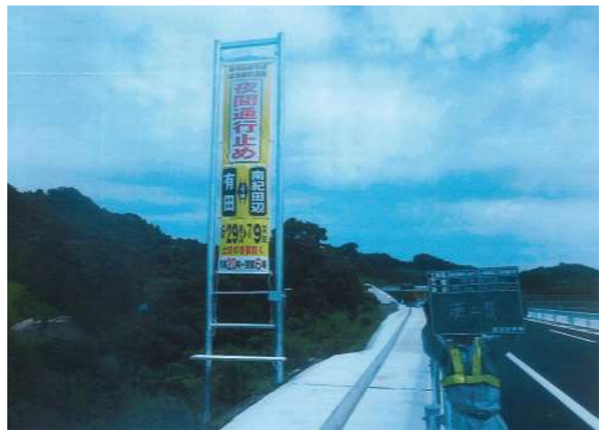
■ 阪和自動車道 懸垂幕装置設置
