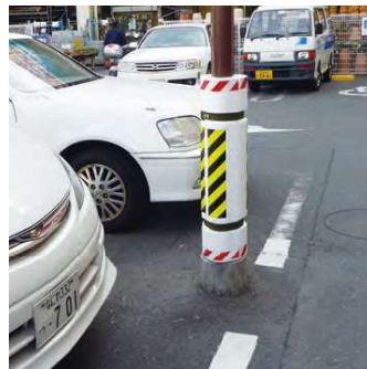
照明柱の防護に。
