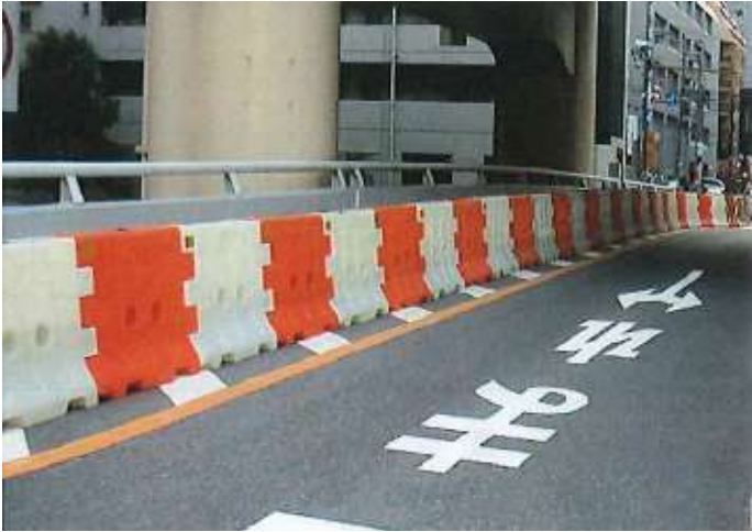
阪神高速道路 高架下 一般道橋梁部
