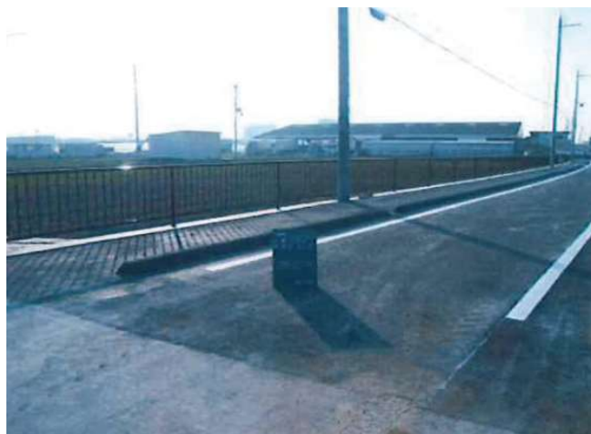
■ 泉南市 交通安全施設設置（転落防止柵）
