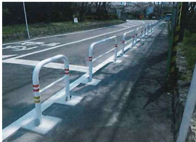
■ 岸和田市 交通安全施設設置（車止め）
